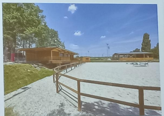
Carrière après travaux - 2023
